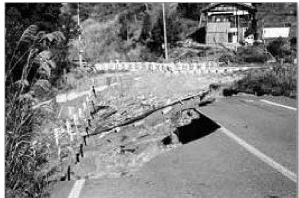
道路の被災状況調査例
